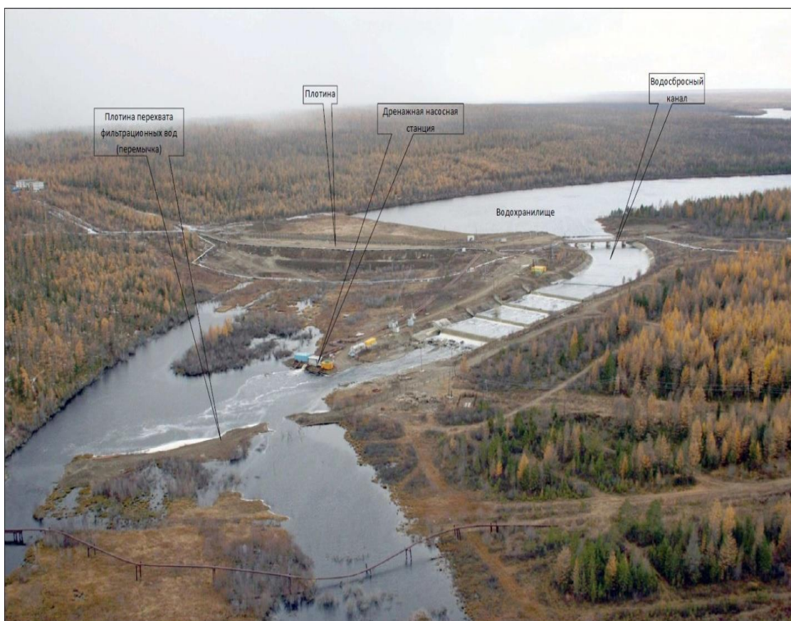
Рисунок 1.7 – Вид на ГЭС гидроузла с нижнего бьефа
